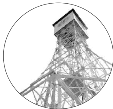
1. Reloj de Montecristi Arq. de Hierro
