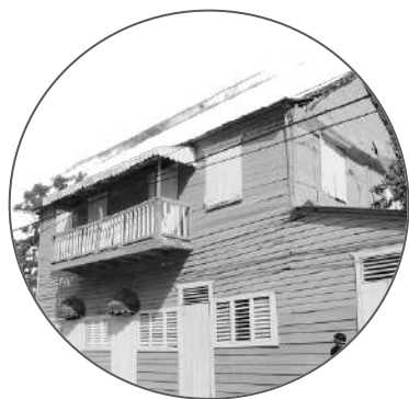
3. Antiguo Hospital Vernácula 2 Niveles
