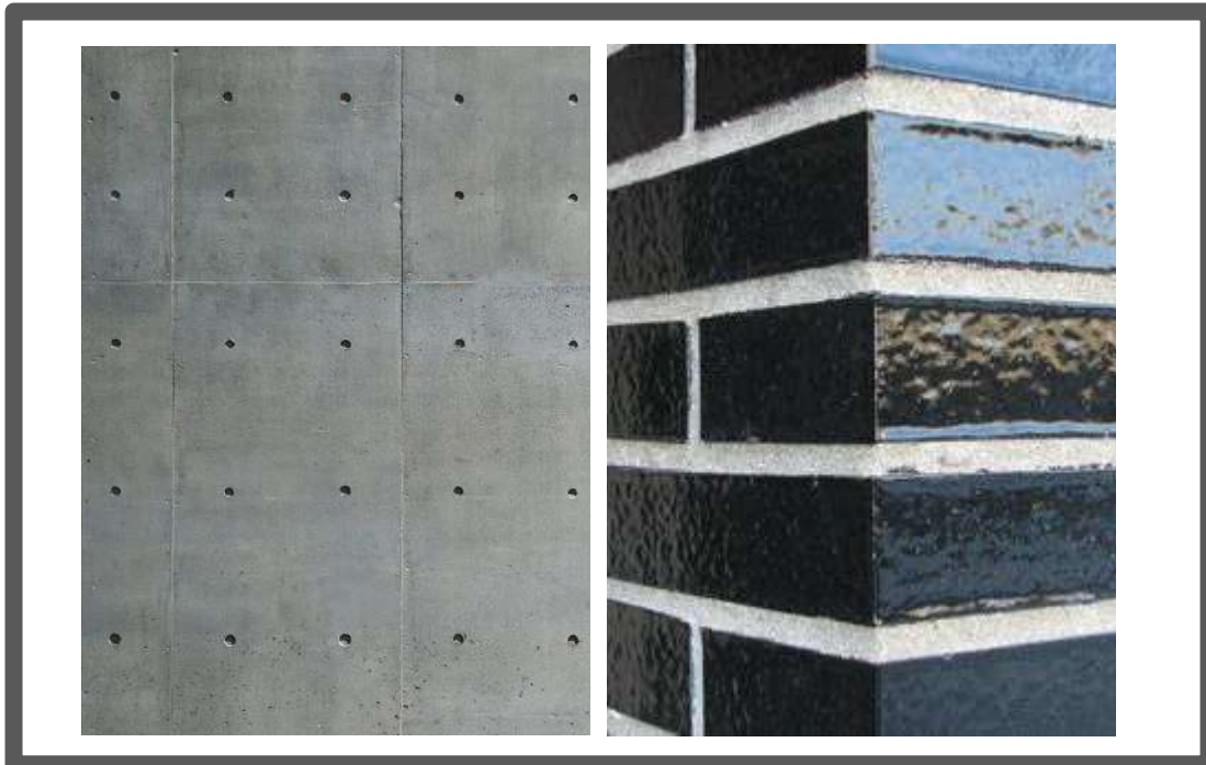
Utilizar materiales resistentes a inundaciones como concreto, el ladrillo vidriado, el aislamiento de espuma y celdas cerradas, los herrajes de acero, la madera contrachapada tratada a presión y de grado marino, las baldosas cerámicas, los adhesivos resistentes al agua, y la pintura epoxi de poliéster,
