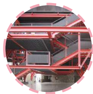
Estructura de Acero a color
